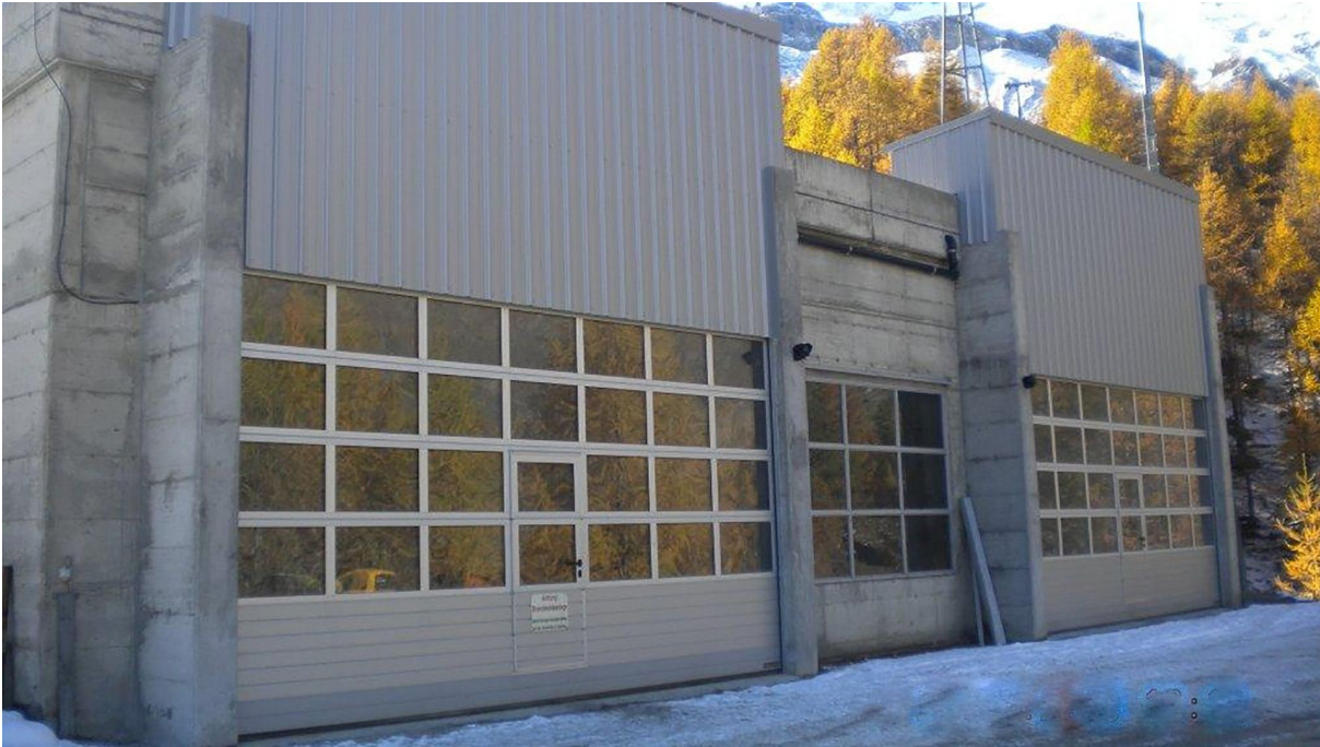
Luftseilbahn, Saas Fee Köstner
